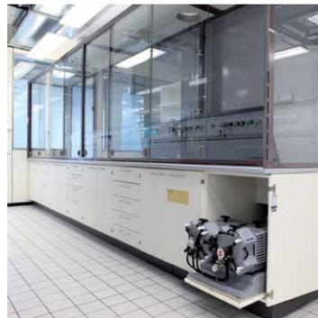
Bombas de vacío ATEX integradas en los muebles de laboratorio. VACUU·LAN® para varias cabinas.
