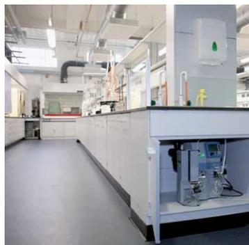
Instalación de la línea de vacío para el laboratorio en la universidad, equipado con condensador Peltronic®, sin conexiones para agua de refrigeración en el interior del armario.
